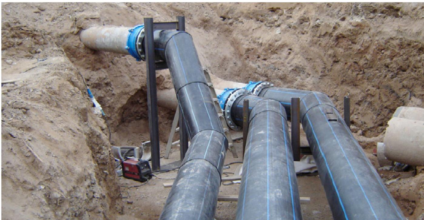
En el caso de la reparación de tuberías de fibrocemento y fundición gris sustituyéndolas por tuberías de materiales plásticos, hay en mercado acoplamientos con características técnicas de comprobada tolerancia. En todo caso, lo más aconsejable es usar tubería del mismo material y calibre. En el caso de utilizar tuberías plásticas es aconsejable que los accesorios de reparación sean resistentes a la tracción.
