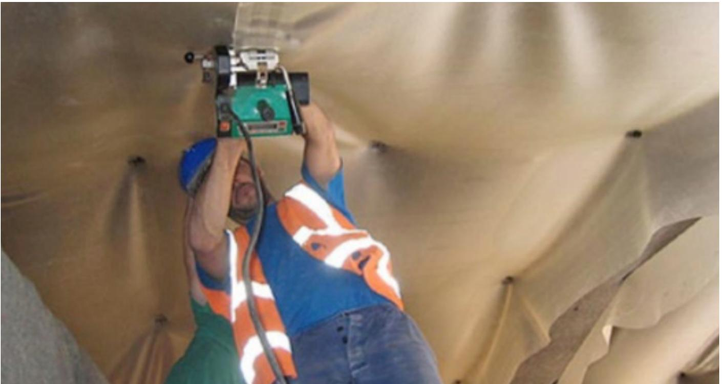
Esta clase de túnel primero se excava y después se reviste empleando anillos de hormigón. La impermeabilización se efectúa con policloruro de vinilo (PVC). Se realiza situando un material protector contra la superficie que nos interesa, y después se instala allí la lámina de PVC. En Europa es el sistema más utilizado.
