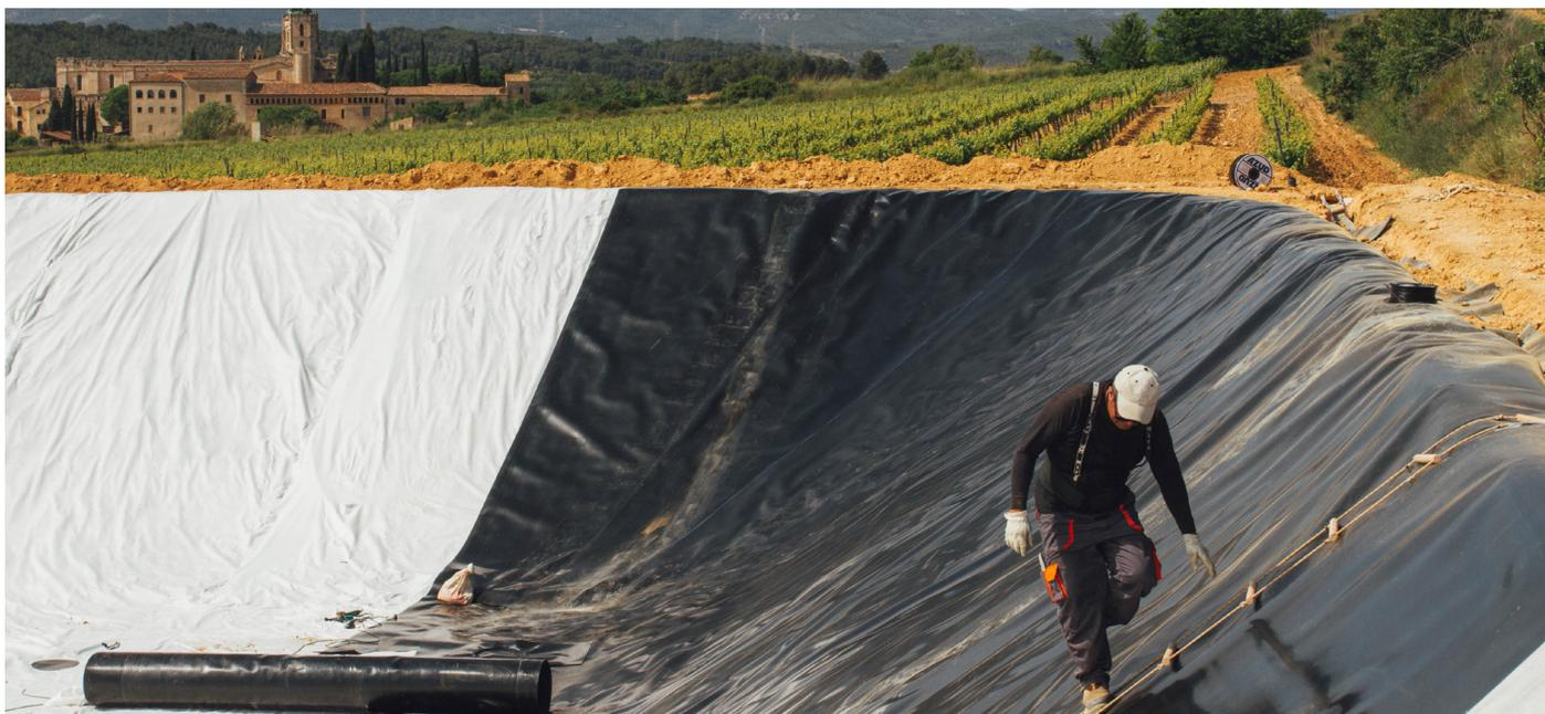
Para evitar que cualquier movimiento del terreno pueda deformar la geomembrana, es fundamental que la superficie de apoyo sea compacta. Tras situarnos en una superficie de apoyo segura, comenzamos a la instalación de la geomembrana.
