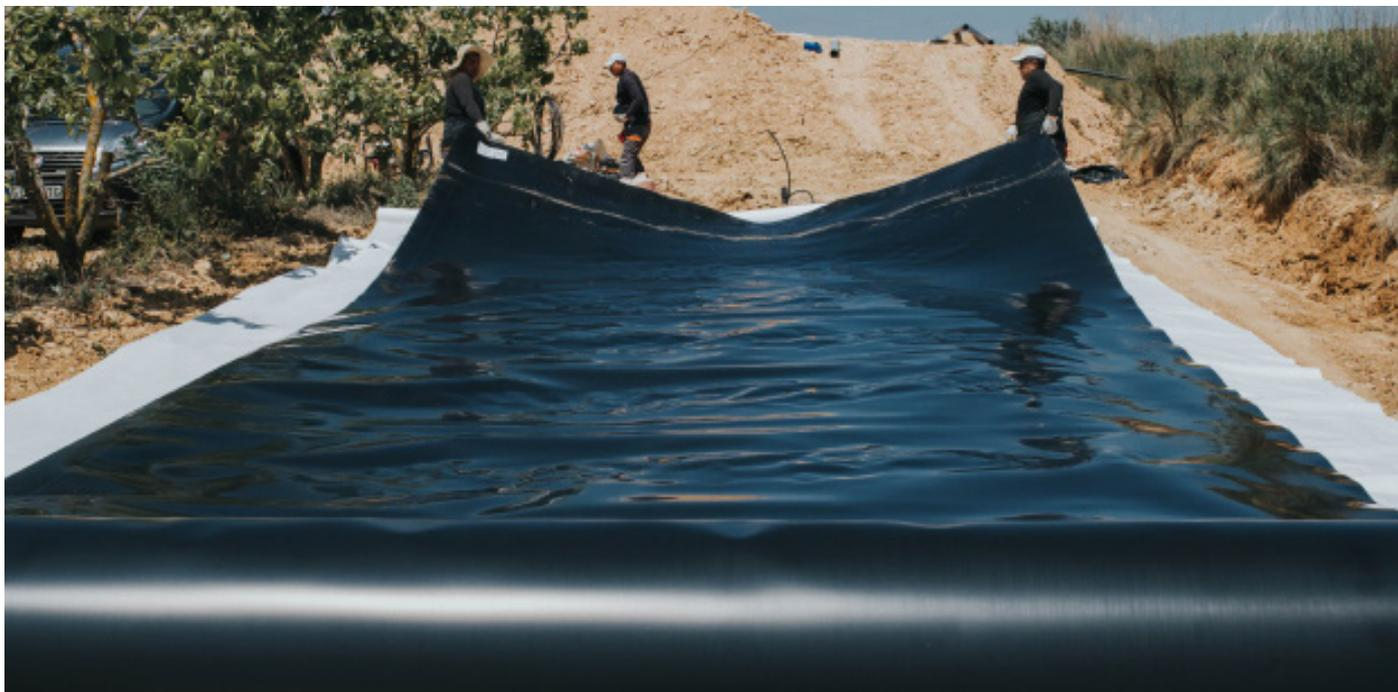
**Para lograr anchos más grandes podemos utilizar rollos de láminas de soldadura longitudinal elaborados previamente en fábrica. Siempre debemos comprobar que las soldaduras son correctas para evitar errores.**
