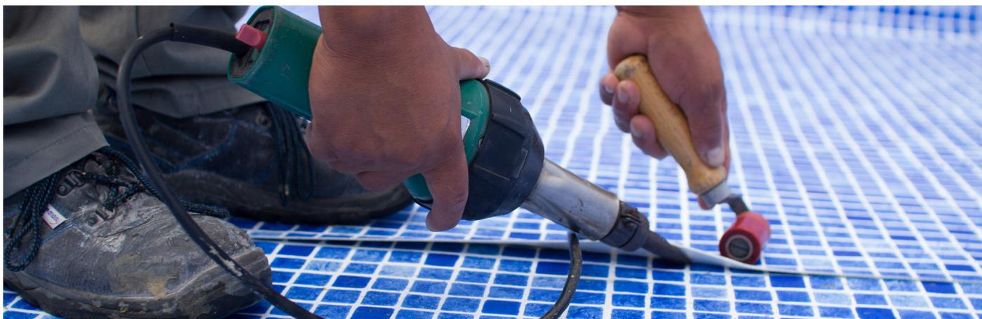
• **Soldadura de lámina de PE para embalses:** La presión se aplica con los rodillos de soldadura. Se regula desde el punto 0 hasta N, donde se adecuará al grosor de cada lámina.
