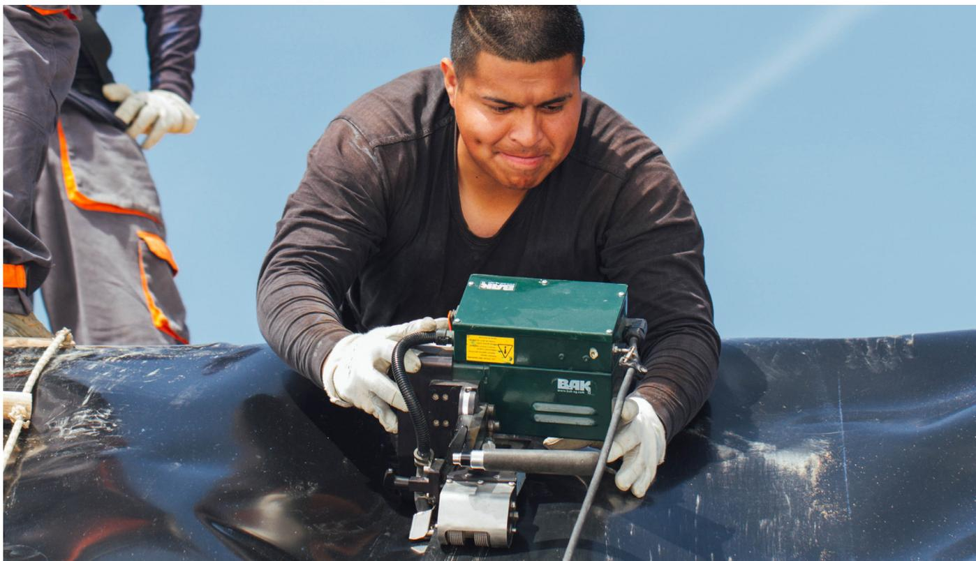
• **Soldadura por extrusión:** La presión se aplica directamente con el peso de la extrusora en la zona que queremos soldar.
