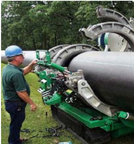
Movimiento hidráulico de las abrazaderas
